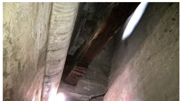
c) Vista della prima catena in legno (fu vera catena ?)
