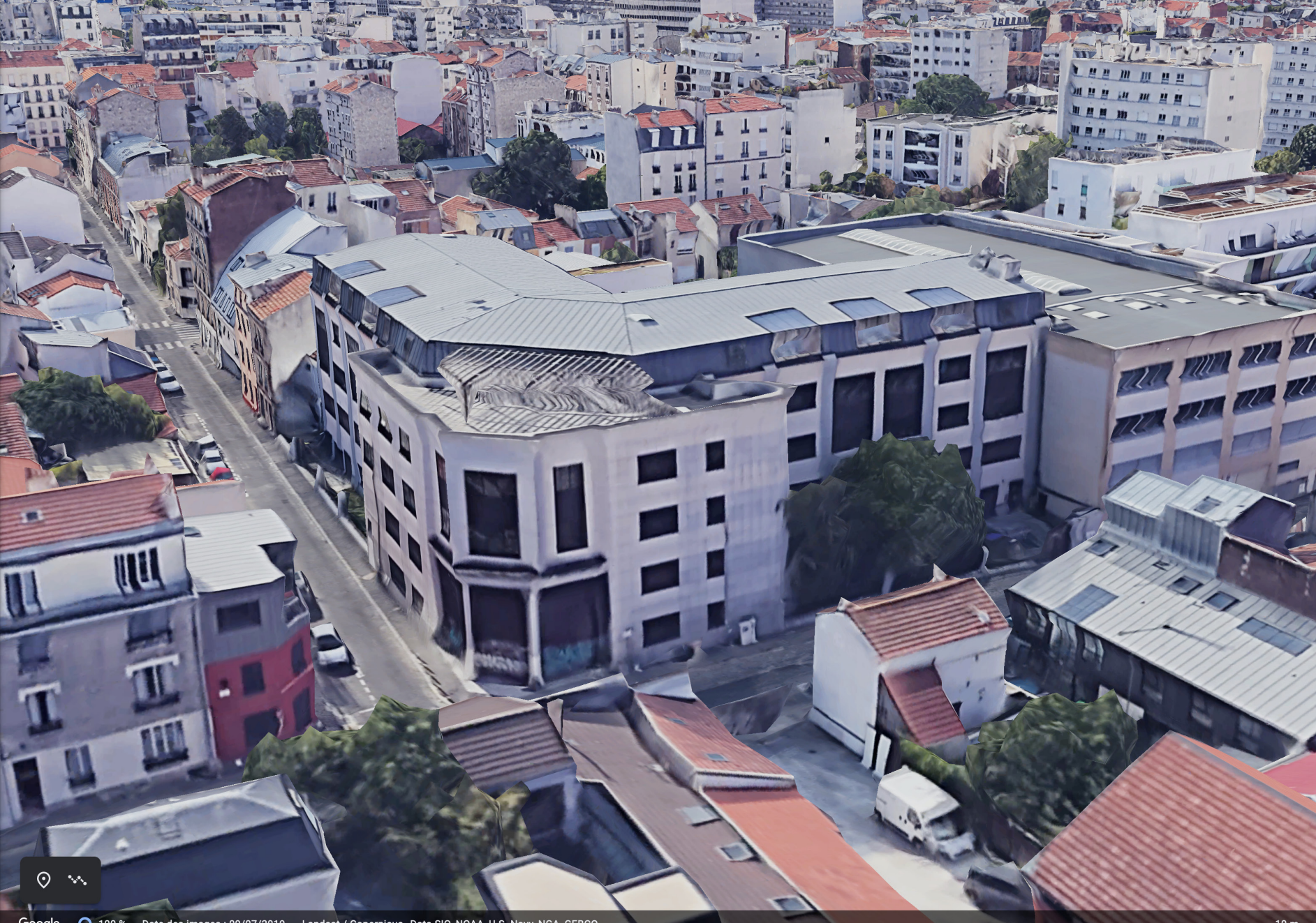
Lycée privé Claude Nicolas Ledoux (EBTP) lycée des métiers de la construction et de son environnement 94300 VINCENNES
