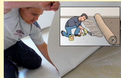
Poser des revêtements de sol (linoléum, moquette ...)
