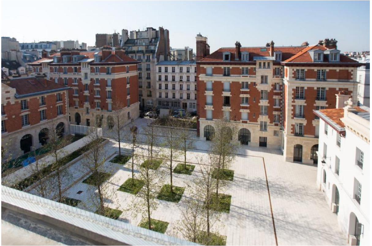
La Caserne des Minimes, logement social rénové par ELOGIE-SIEMP dans le Marais. (crédits Joséphine BRUEDER / Ville de Paris)
