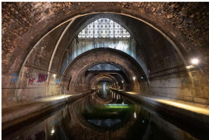
Canal Saint-Martin, sous le boulevard Richard Lenoir ( crédits Joséphine BRUEDER / Ville de Paris)
