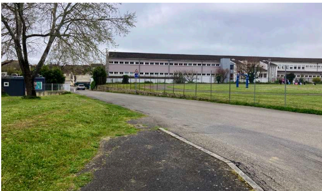
Vue du terrain sur le collège
