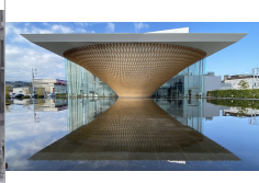
Shigeru Ban, Mt. Fuji World Heritage Centre , 2017, centre d'interprétation culturelle, structure en bois (cèdre local) et béton armé, hauteur env. 21,3 m, Fujinomiya (préfecture de Shizuoka), Japon.
