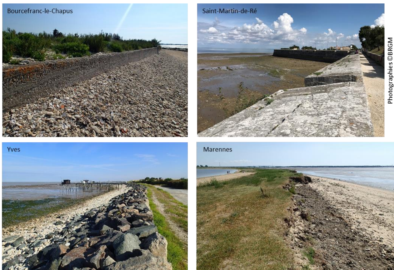
Illustration 37 - Exemples d'ouvrages longitudinaux présents sur le littoral de Charente-Maritime considérés dans cette étude. Bourcefranc-le-Chapus : mur en béton, Saint-Martin-de-Ré : mur maçonné, Yves : enrochement, Marennes : levée de terre.
