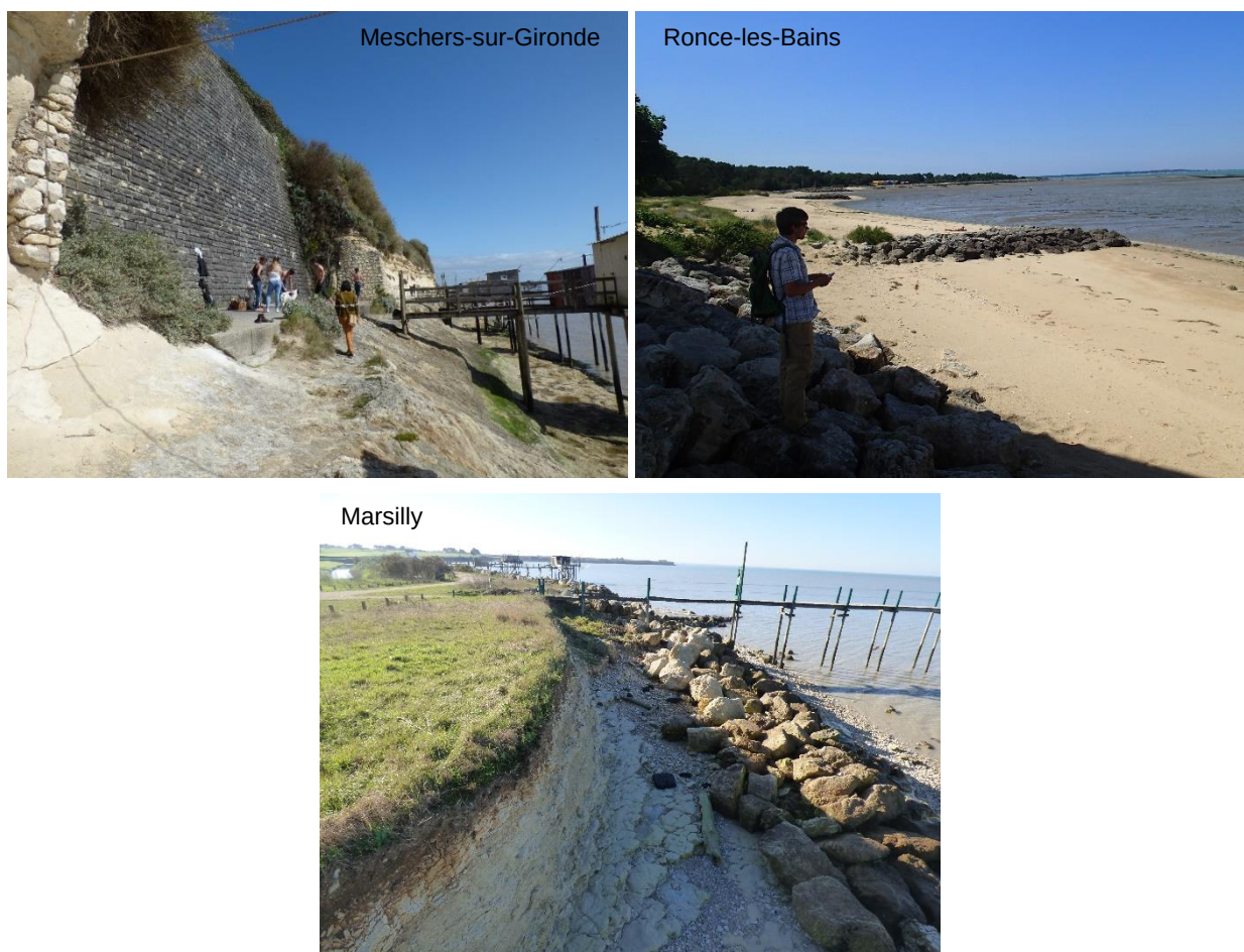
Illustration 38 - Exemples d'ouvrage en falaise (à gauche), transversal (à droite), et déconnecté du trait de côte (en bas), non considérés dans cette étude
