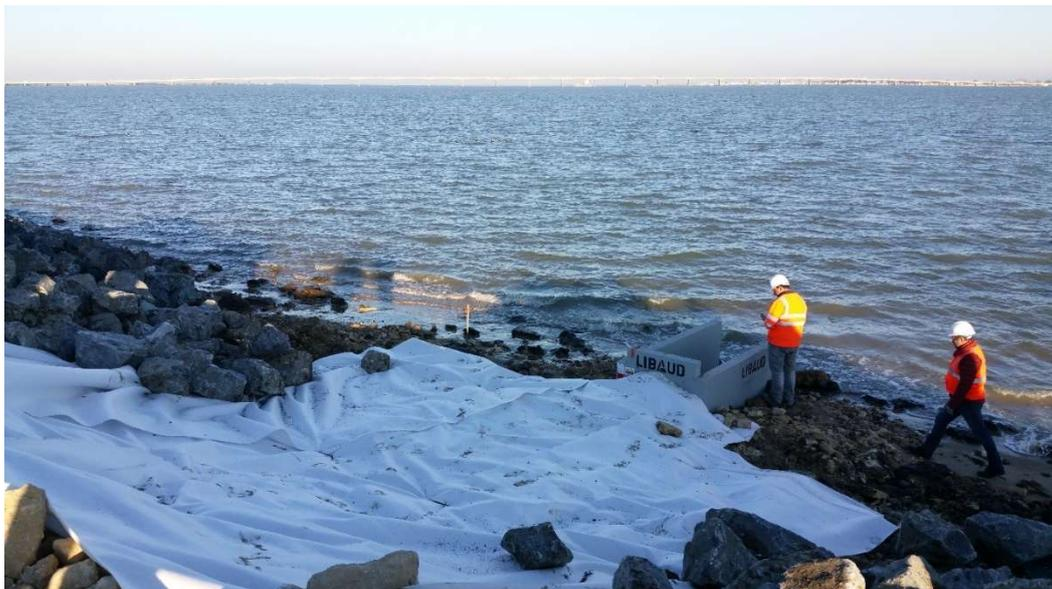
Figure 40: Réalisation d'un ouvrage hydraulique, pose de géotextile et d'encrochement
