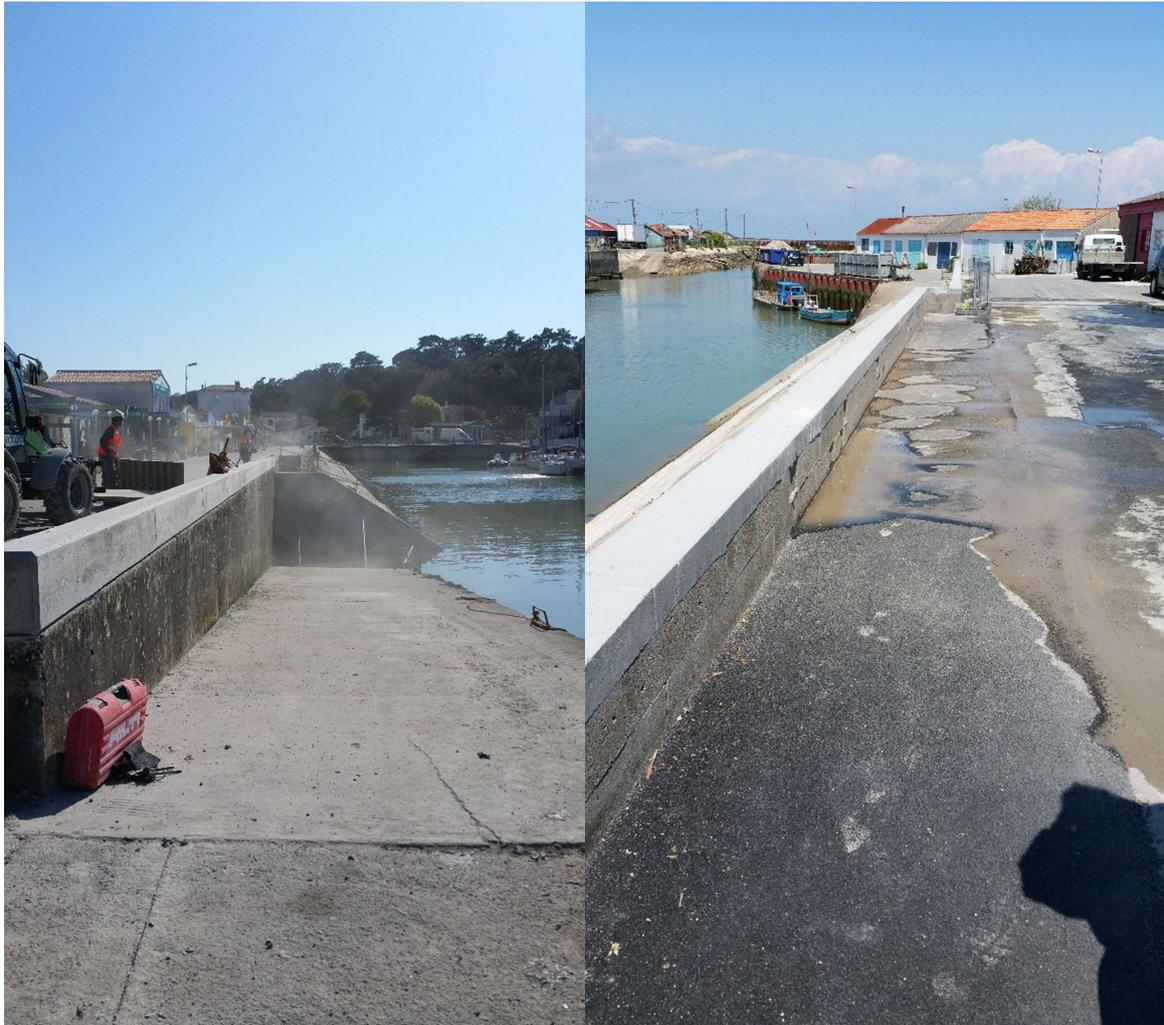
Figure 39: Réalisation du muret anti-submersion sur le port de Saint Trojan Les Bains
