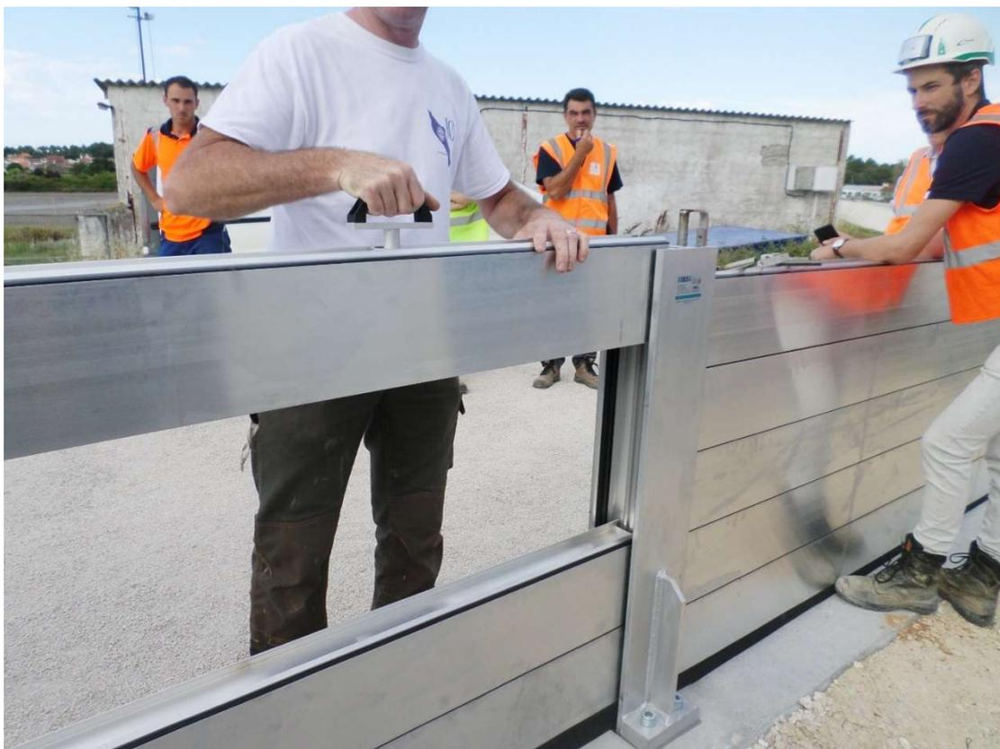
Figure 41: Premier test de pose des batardeaux à Saint-Trojan Les Bains (5 juillet 2017)
