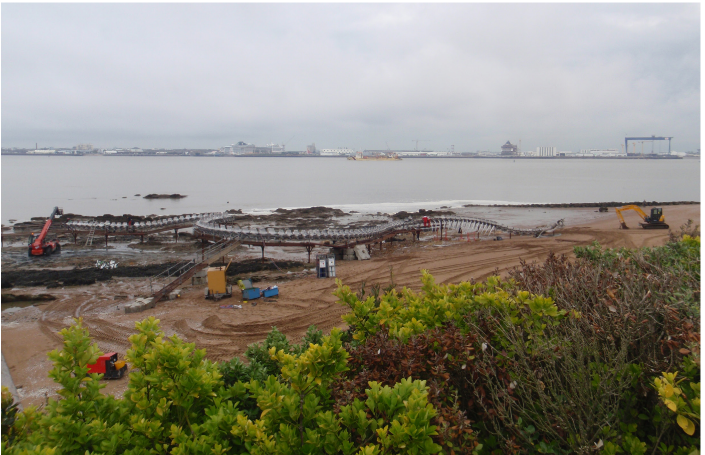
Vue générale du chantier, depuis le point de vue. © LVAN.
