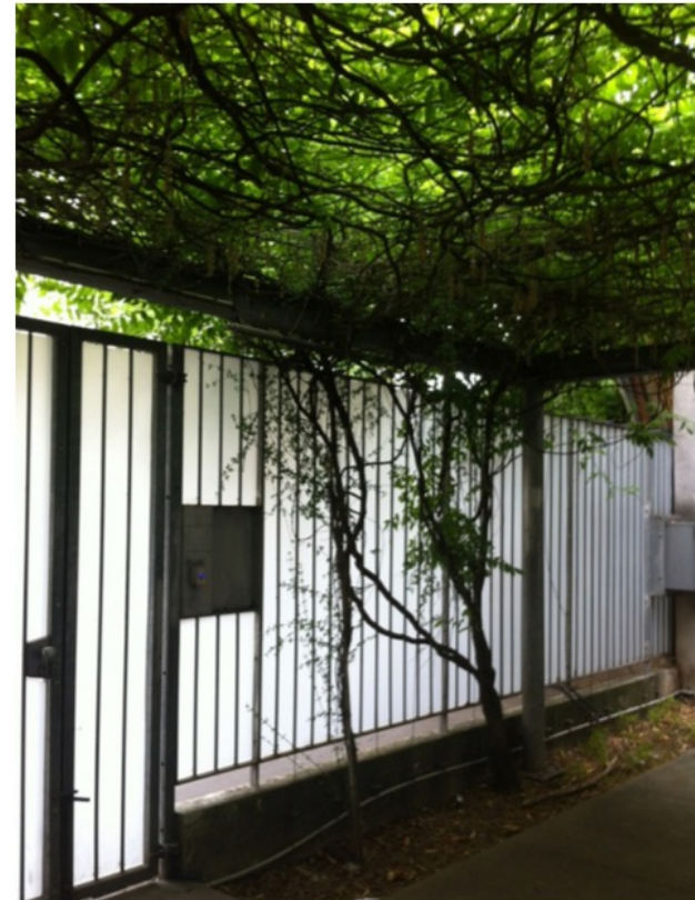
Pergola ajourée, structure porteuse acier (support de luminaires), avec fils guides inox, crèche des Maussins, Paris
