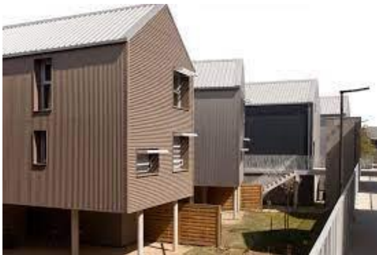
Construction sur pilotis
