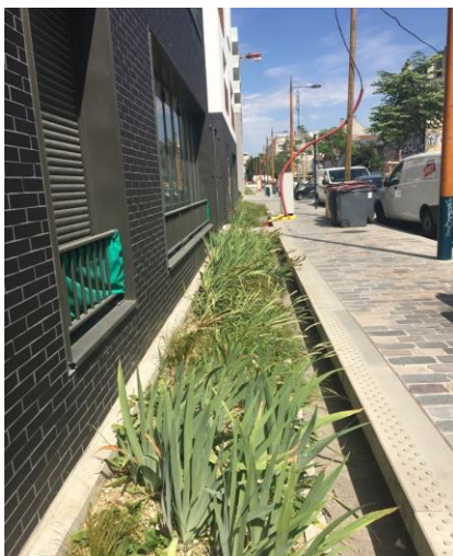
Fosse en pied de façade
