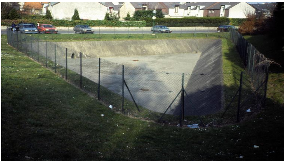
Bassins de rétention à ciel ouvert
